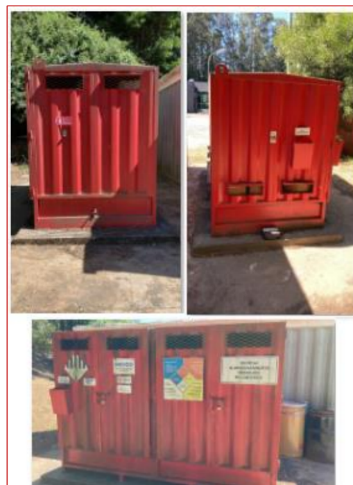
Bodega de Sustancias Peligrosas UCSC
